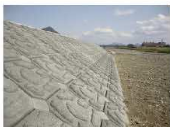
連結部着色コンクリート処理
