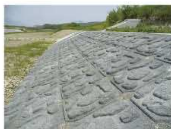
連結部碎石処理
