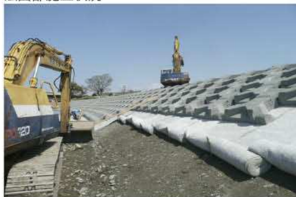
法面部施工状況
