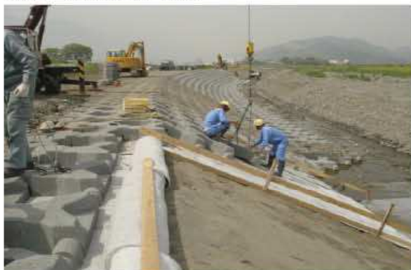
天端・法面部施工状況
