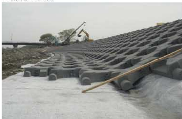
垂部施工状況
