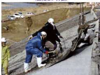
ブロックマット設置 （固定ピン打設）
