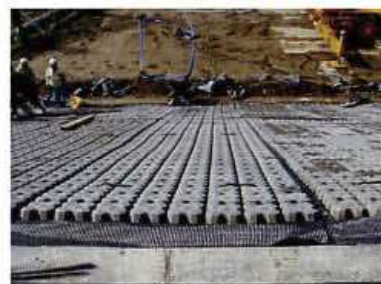
ブロックマット敷設完了
