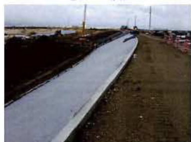
遮水シート敷設
