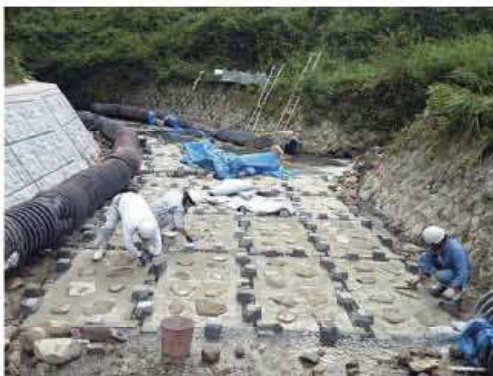
2t標準施工 植石施工
