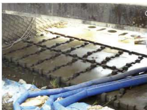
2t標準施工 橋梁下施工
