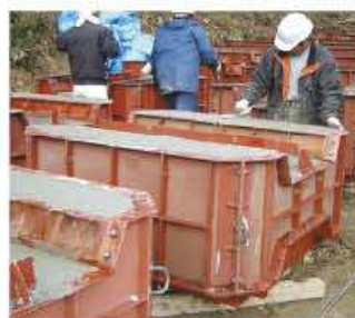
③コテ均し、養生
