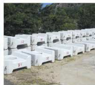
④型枠脱型
