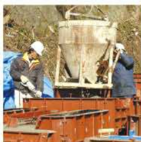
②コンクリート打設
