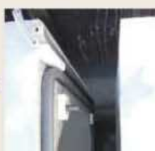
TBジョイントバー挿入状況
