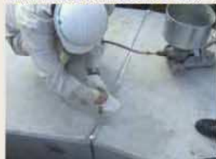
上部より頂版天端部へ注入(曲線部)
