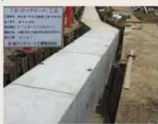
曲線部も直線部と同じ施工！
