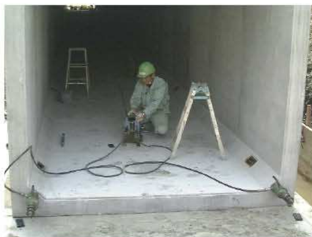
※縦締は2連同時緊張ジャッキを使用
