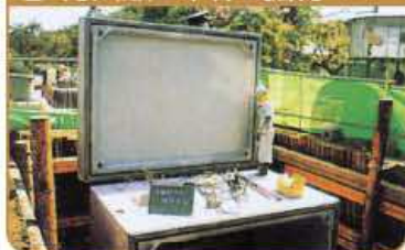
5 背面版D本体C据付
