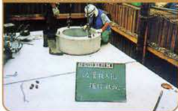
10 吸管投入孔据付
