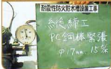
7 縦締工PC鋼棒緊張
