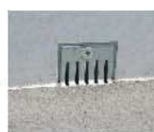
車道部排水孔 (50cm間隔)
