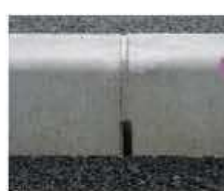
歩道部排水孔
