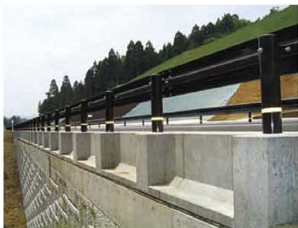
補強土壁直上
