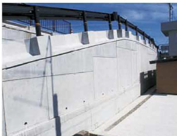
勾配変化部設置
