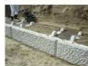
5.間詰材・裏込材転圧
