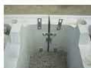
2.縦・横連結金具取付
