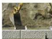
4.間詰材・裏込材投入
