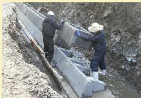
③ 2 段目以降、本体ブロックを据付
