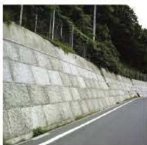
道路改良工事
