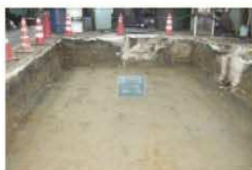
敷設面のチェック
