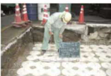
間詰碎石の充填確認
