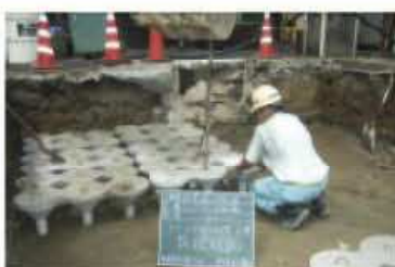
コマ型ブロック敷設
