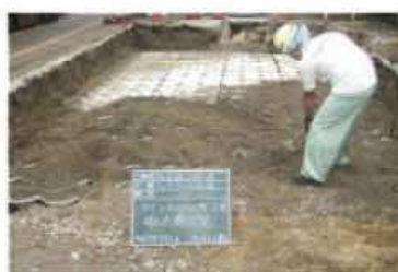
間詰碎石の充填・締め固め
