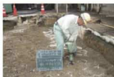
間詰碎石の充填・締め固め
