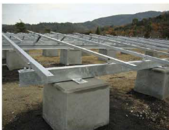
インサート固定状況
