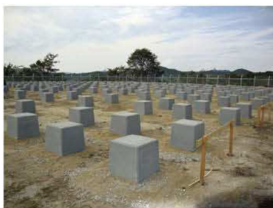
基礎ブロック設置状況
