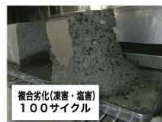
普通コンクリート
