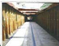
基礎コンクリート上に 走行ガイドを設置
