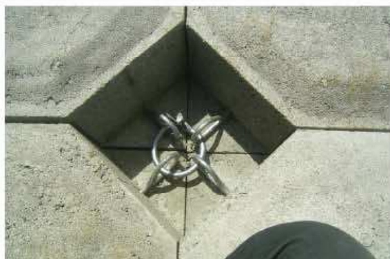
⑦ ブロックどうしを専用金具で連結する。
