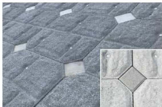
⑧ 連結部は間詰コンクリートを充填する。 間詰ブロックを使用する場合はこの上に貼る。
