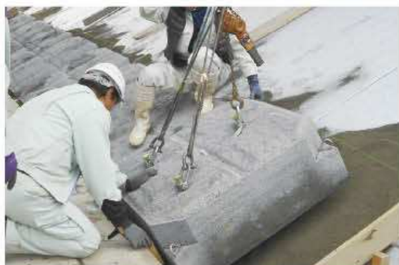
⑤ ワ이어長さを勾配に合わせ製品を据え付ける。
