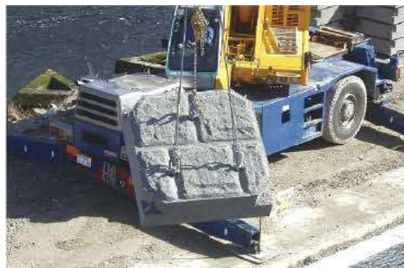
④ ブロックは専用の吊り金具を確実に取り付ける。
