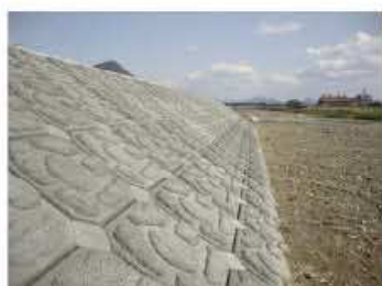
連結部着色コンクリート処理
