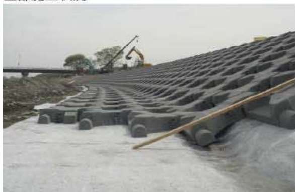
垂部施工状況
