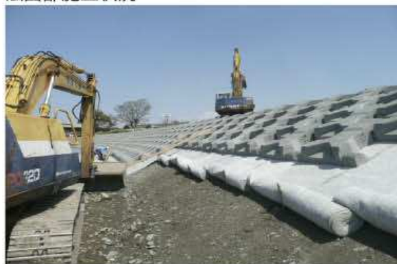
法面部施工状況
