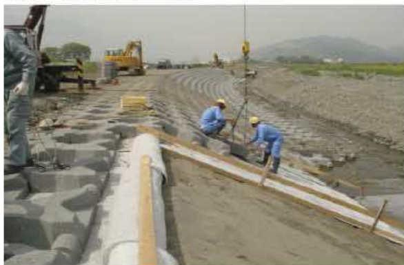
天端・法面部施工状況
