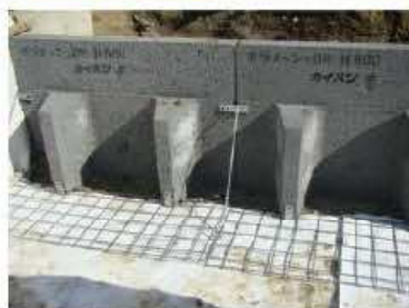
ブロック設置、金網取付
