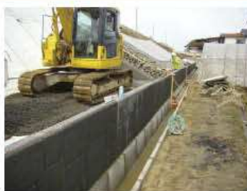
ドレーン材投入
