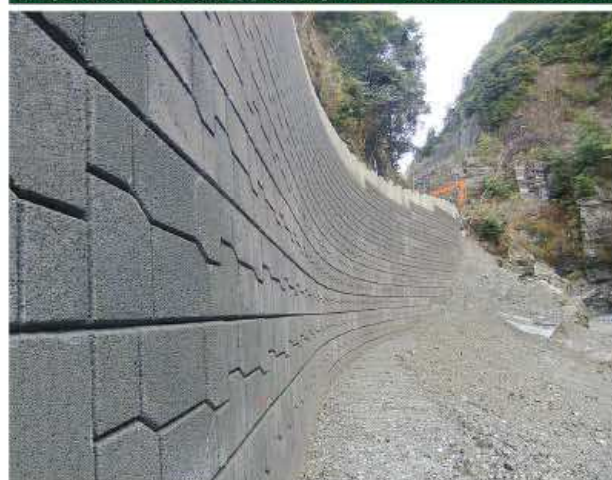
山間部道路拡幅 護岸工
