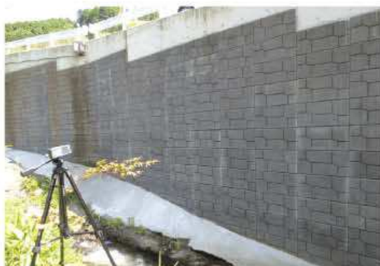
震度6強 最大高さH=7.2m 異常なし
