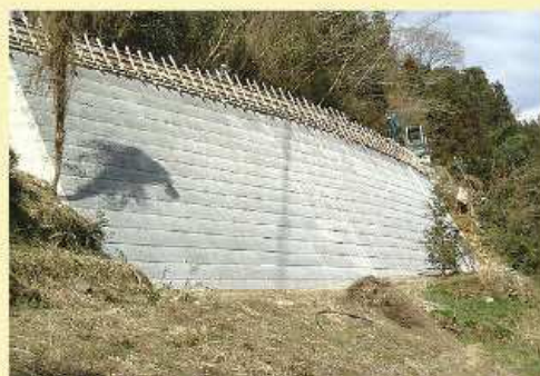
⑧ 移行③～⑦を繰り返し、最上部に天端工を施工
