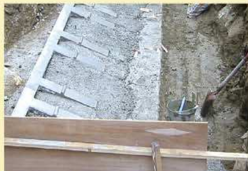
② 根石ブロックの胴込コンクリート打設
