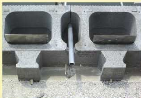
④ 水抜パイプはノックアウト部を割り欠き設置
