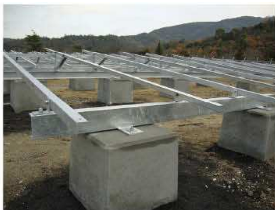
インサート固定状況
