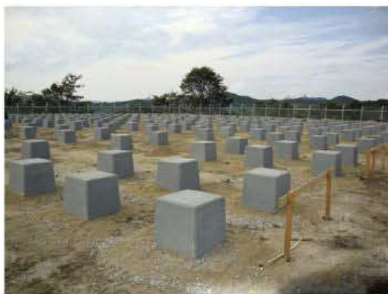
基礎ブロック設置状況
